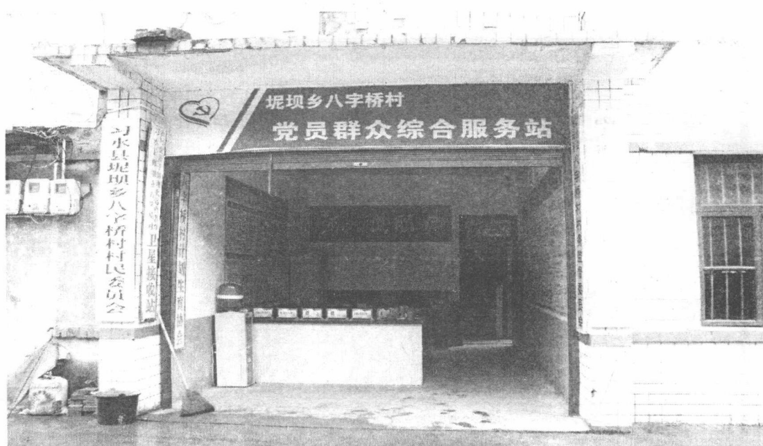
八字桥村委会办公楼
