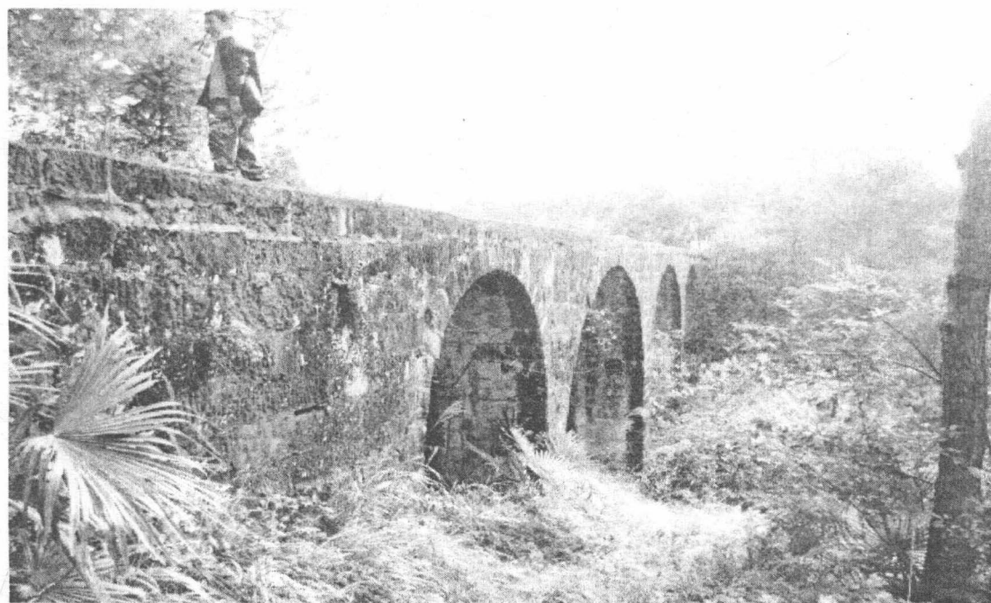
苦角坝水利工程人工天槽（李家榜）
