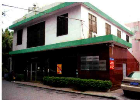
▲文化站办公楼左侧面
