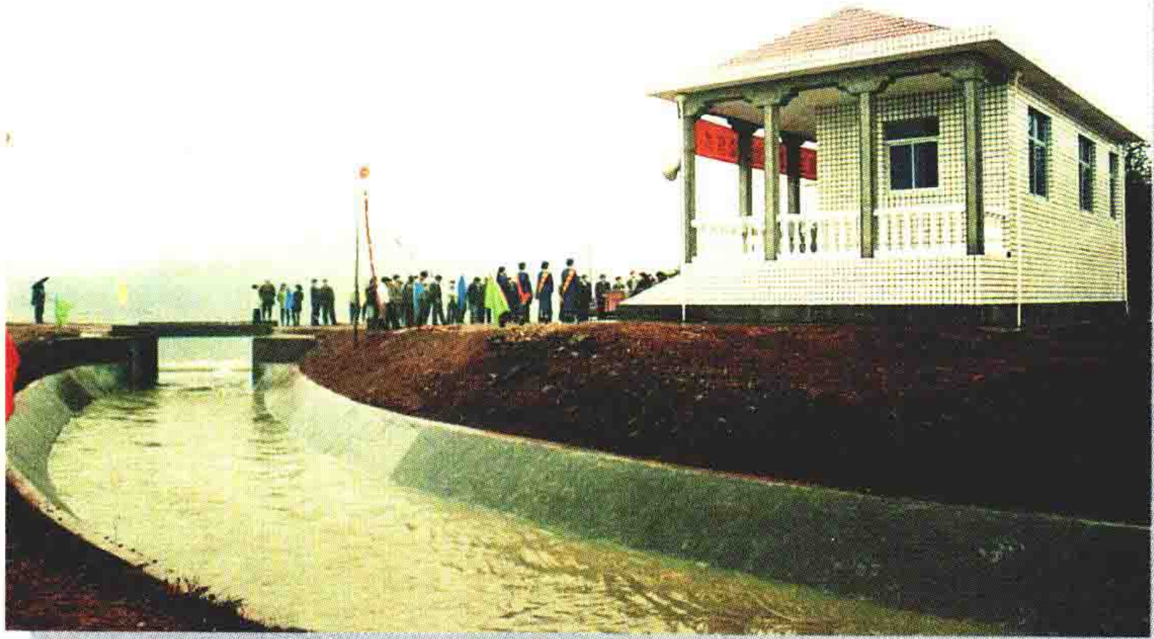
乌溪江引水工程渠道管理房
