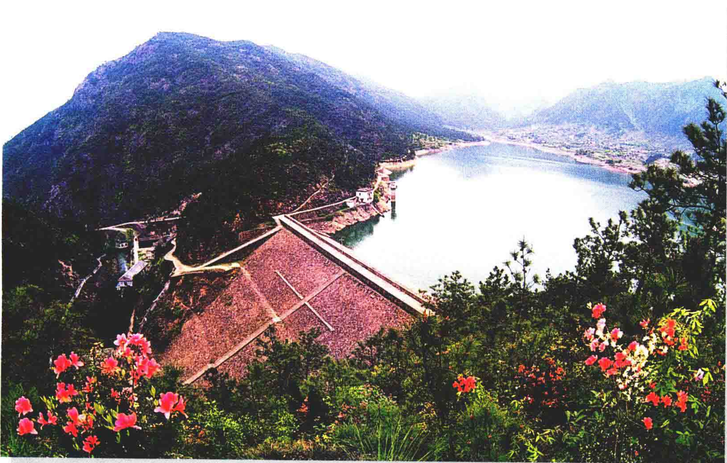
城头水库大坝
