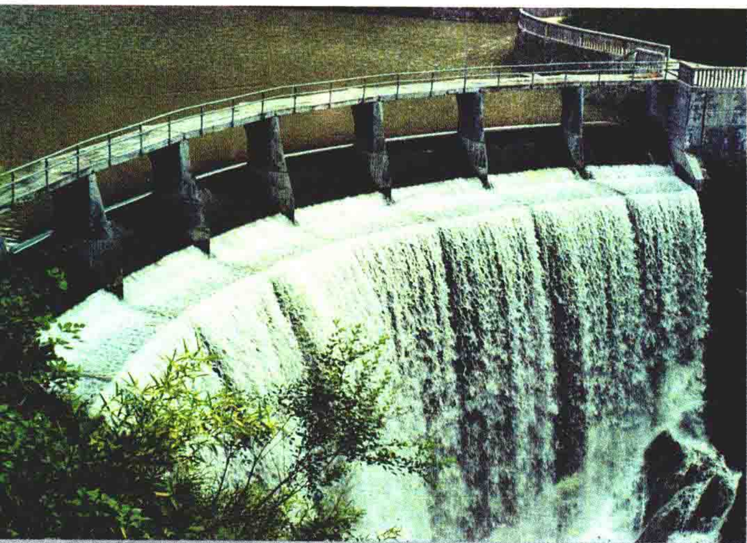
城头水库南干渠渠首拱坝
