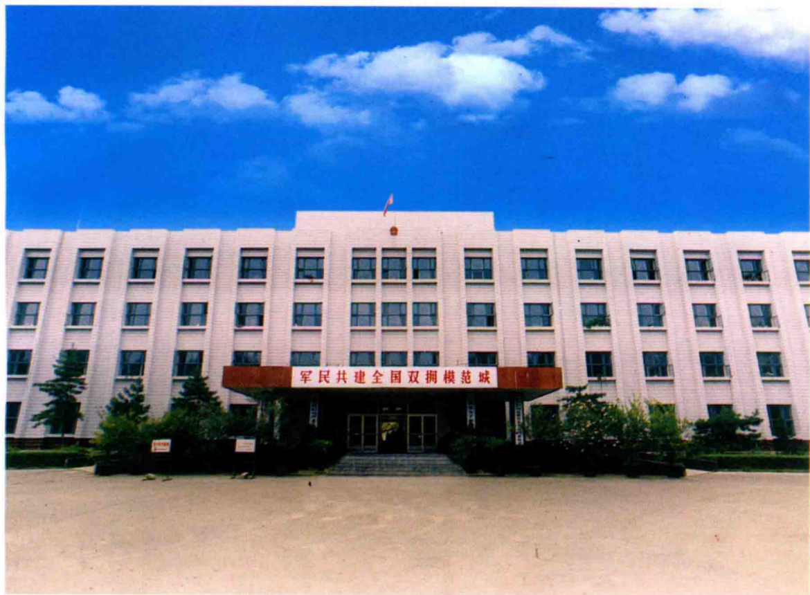
太子河区机关大楼
