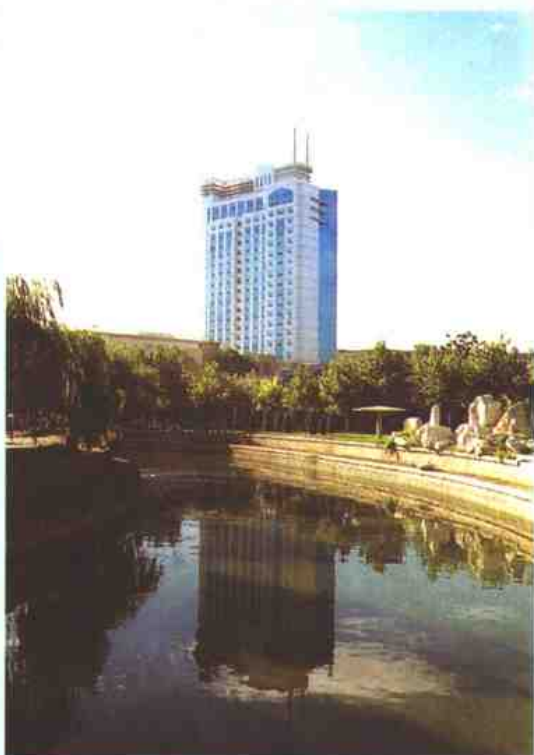
市级机关办公大楼
