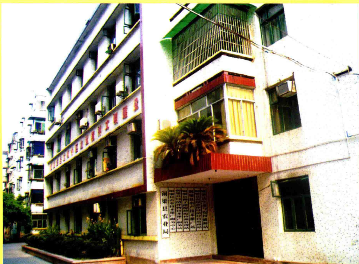
农业局办公大楼
