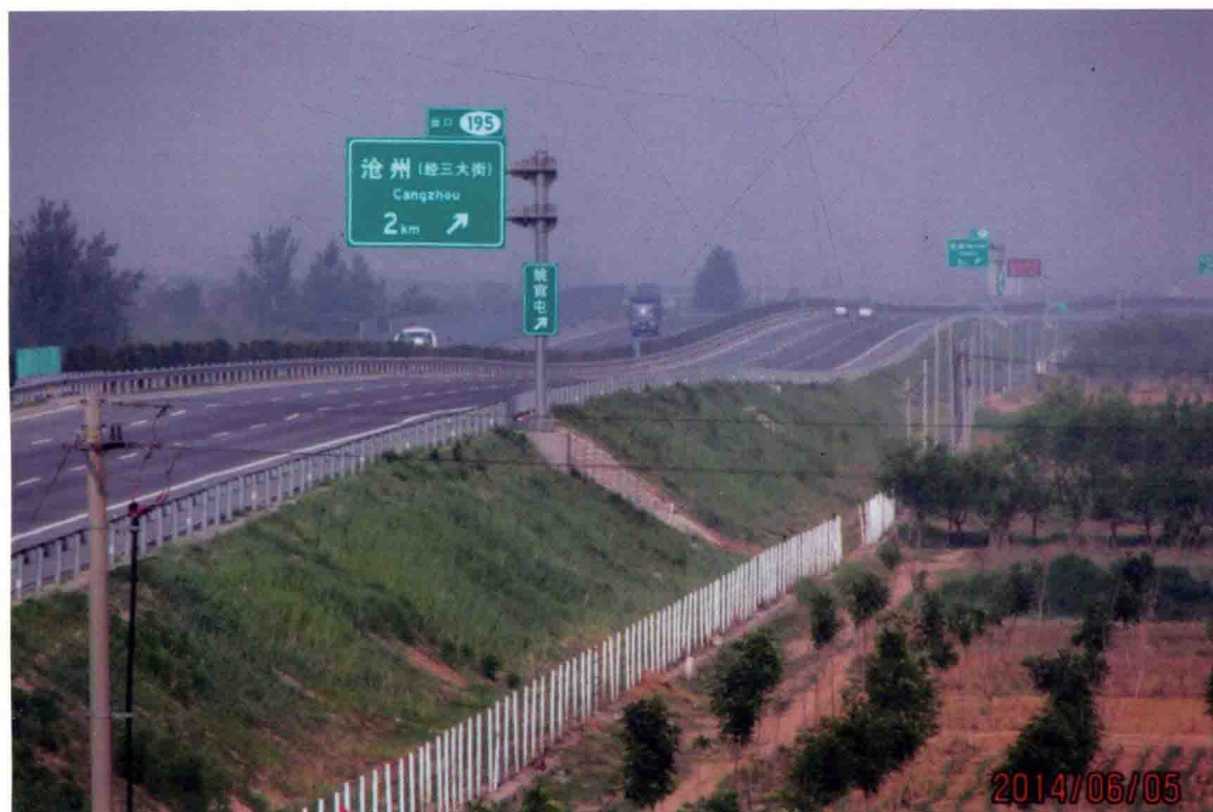
便利的交通—途径张辛庄村的廊沧高速路
