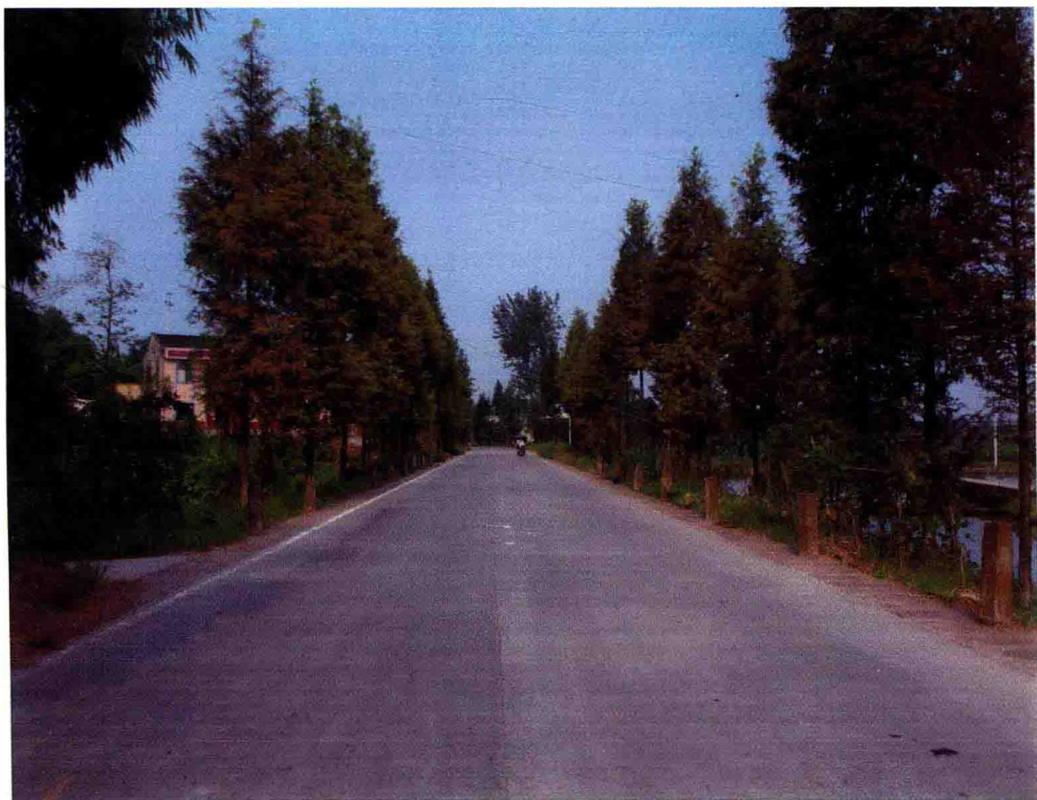
宽敞的新公路
