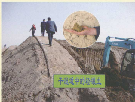
图 1-3-29 干湿适中的轻壤土筑墙
