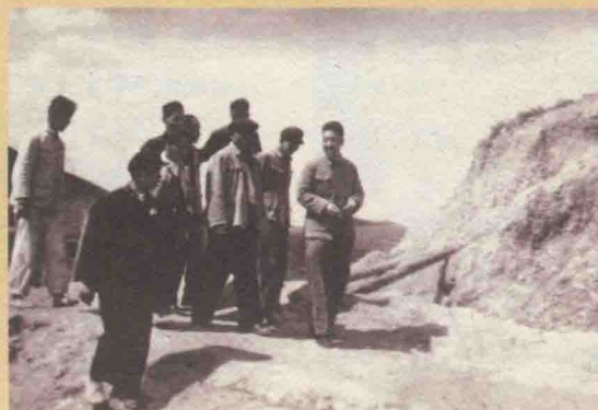
■ 福建省原省长魏金水(右一) 视察 惠女水库建设工地
