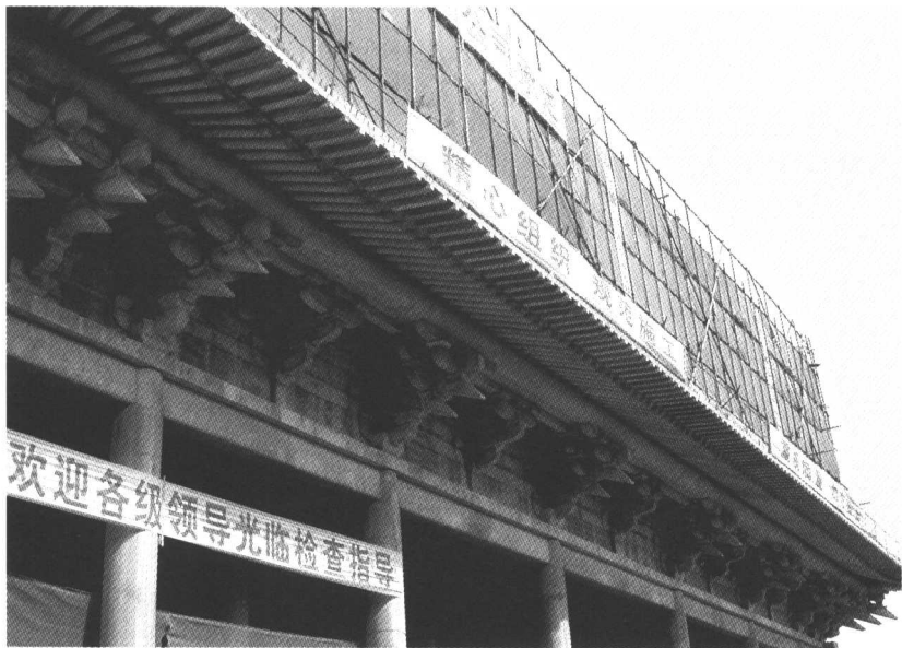
图 1-2 混凝土施工效果
