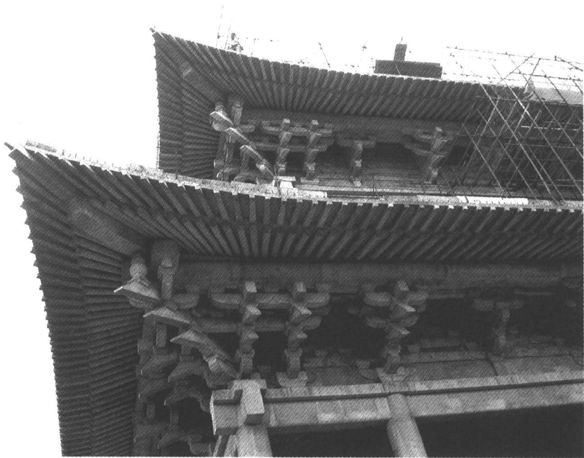
图 1-3 钢筋混凝土外飞檐及翼角翘飞
