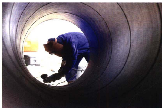
右中 2002年7月4日，西部开发的标志性项目——西气东输管道工程正式开工兴建。这是工人李银强在进行管线防腐处理的第一道工序——管线清口。
