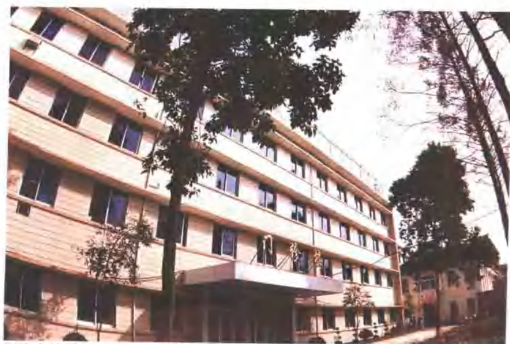
门诊大楼（1982年9月落成）
