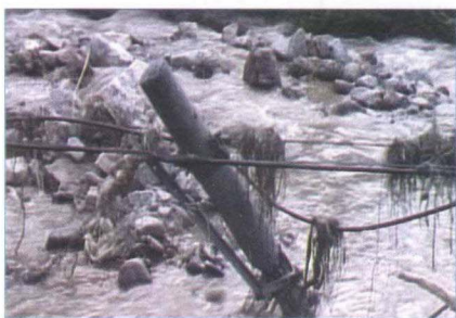
2006年“7·15”洪灾·洪水冲毁10KV以上输电线路461公里。
