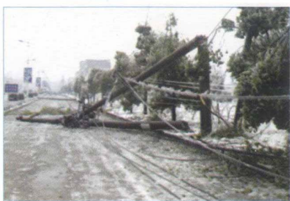
2008年冰灾·冰雪压断的通信光缆。
