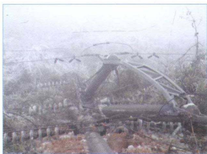
2008年冰灾 • 冰雪压倒输电铁塔12座。
