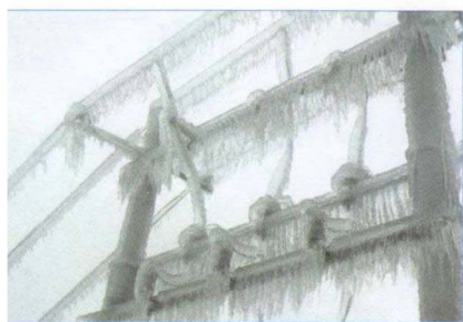
2008年冰灾·挂满冰凌的变压器架。
