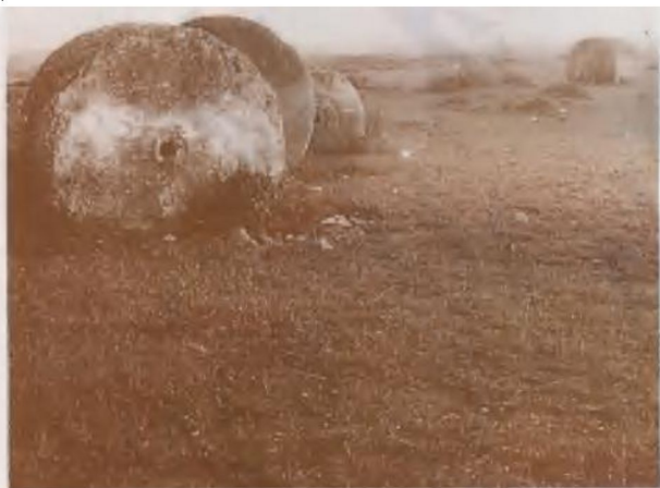
1938 年修建 芷江机场时,用来 碾压机坪的石滚
