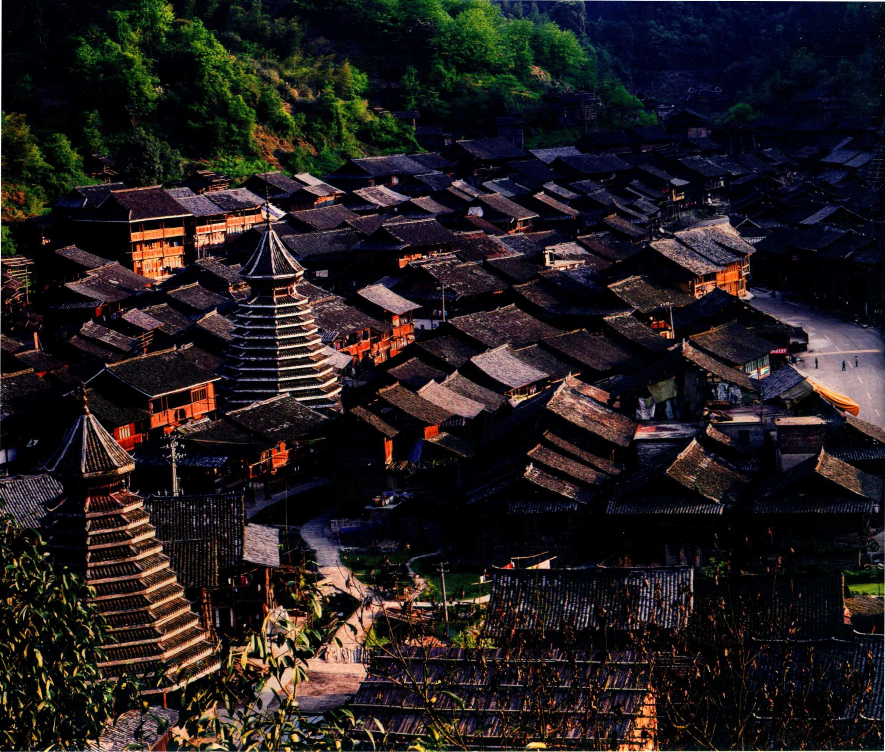
侗族木构建筑营造技艺 摄影 / 胡光华
