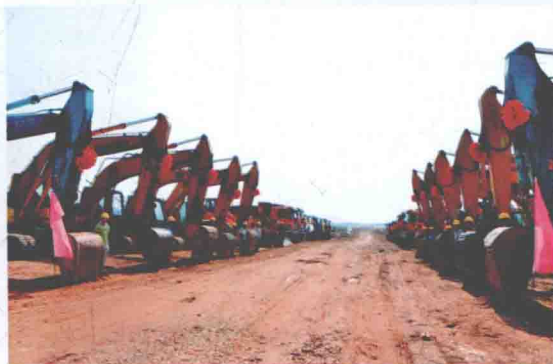
2014年9月24日，海丰生态科技城中心启动区市政工程正式动工
