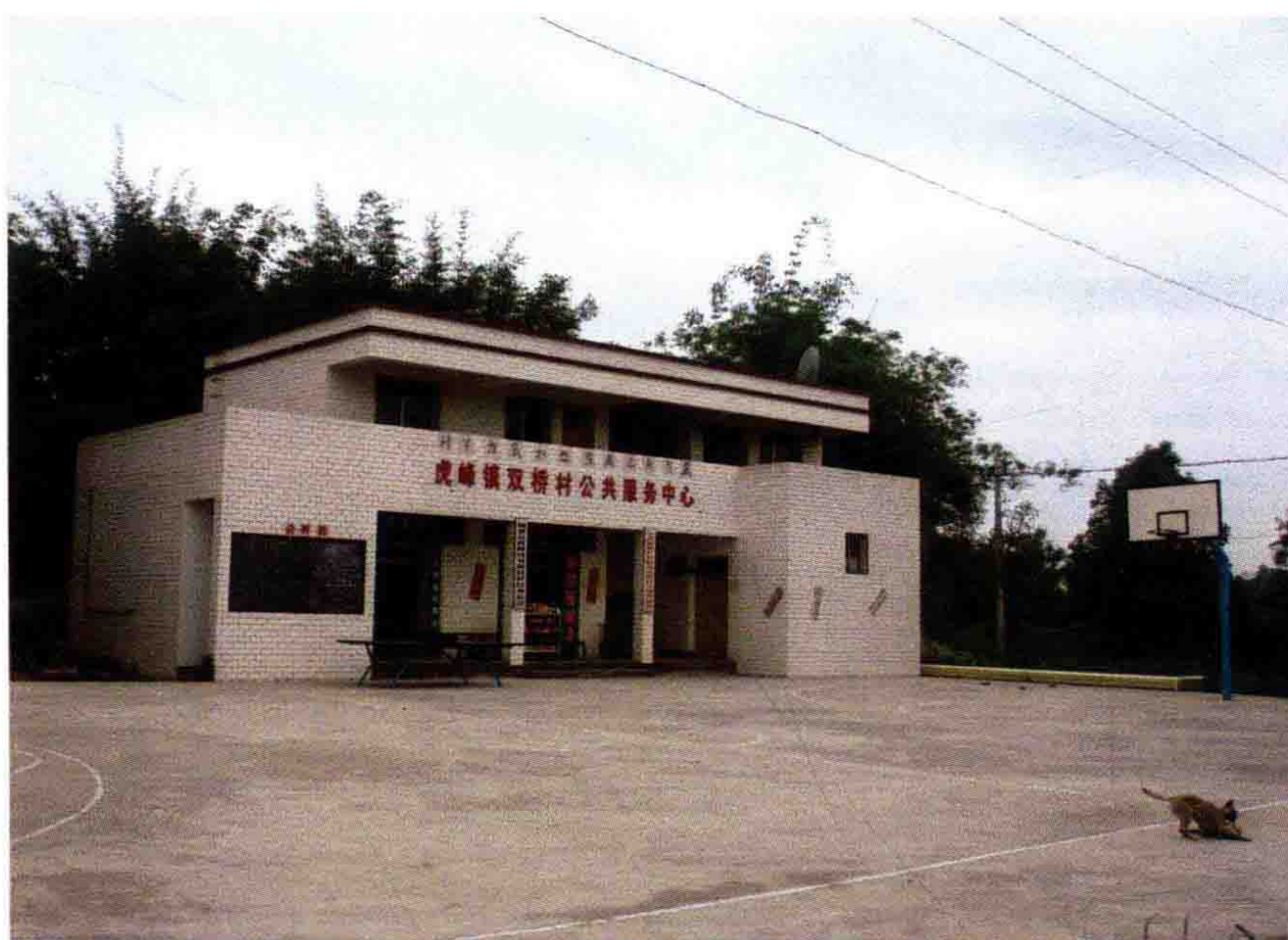
虎峰镇双桥村公共服务中心
