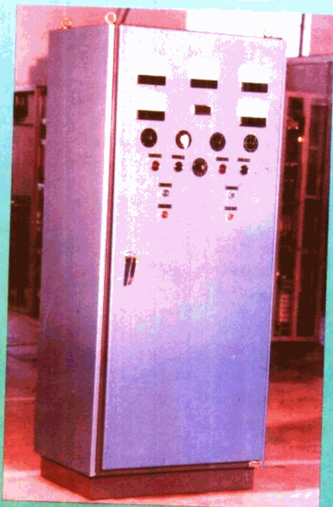
XFWZ-2A 自启动柴油发电控制箱
