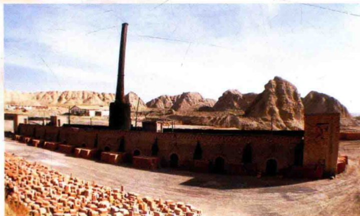
元年工贸有限公司砖瓦厂
