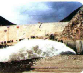
沟后水库复建竣工
