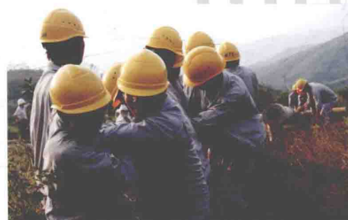
2013年9月26日，超强台风“天兔”在汕尾登陆，电网设施受灾严重。图为在海丰县赤石镇，供电抢修队队员合力拉电杆。
