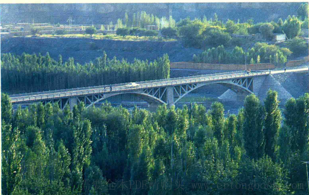
煤窑沟公路桥
