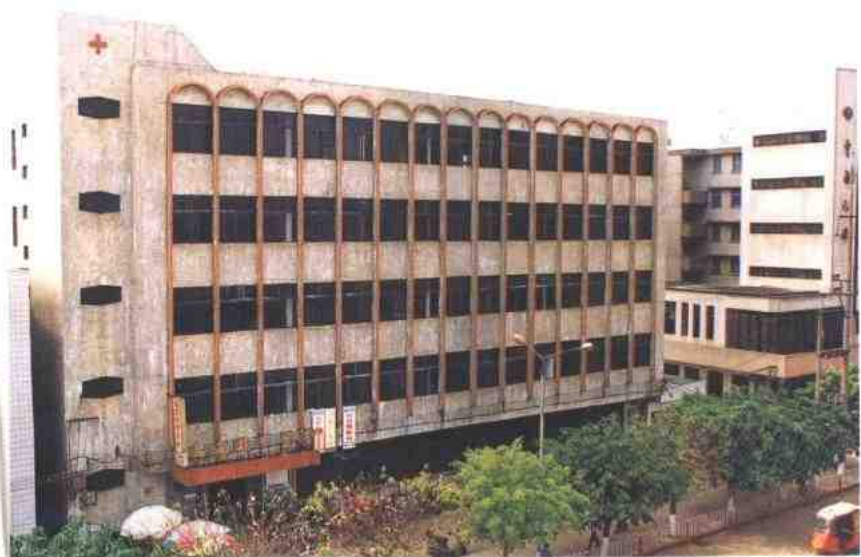
图为临高县中医院门诊大楼
