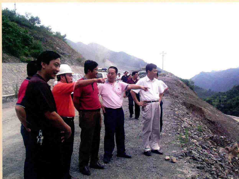
市长慕德贵(右三)检查石埡子电站建设工程
