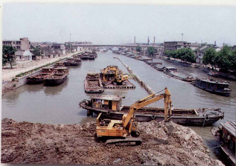
航道拓宽施工
