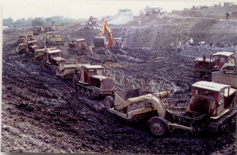
筑坝断航施工
