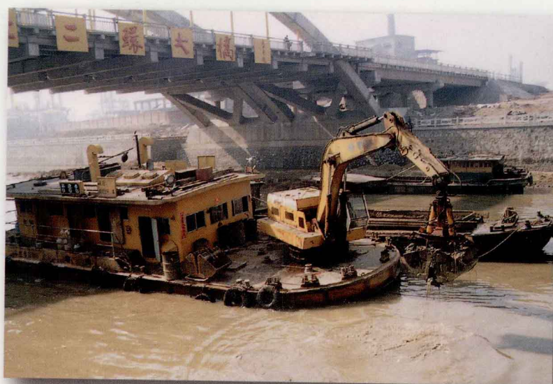
水下土方施工
