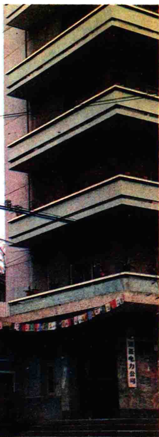
▼ 电力公司大门
