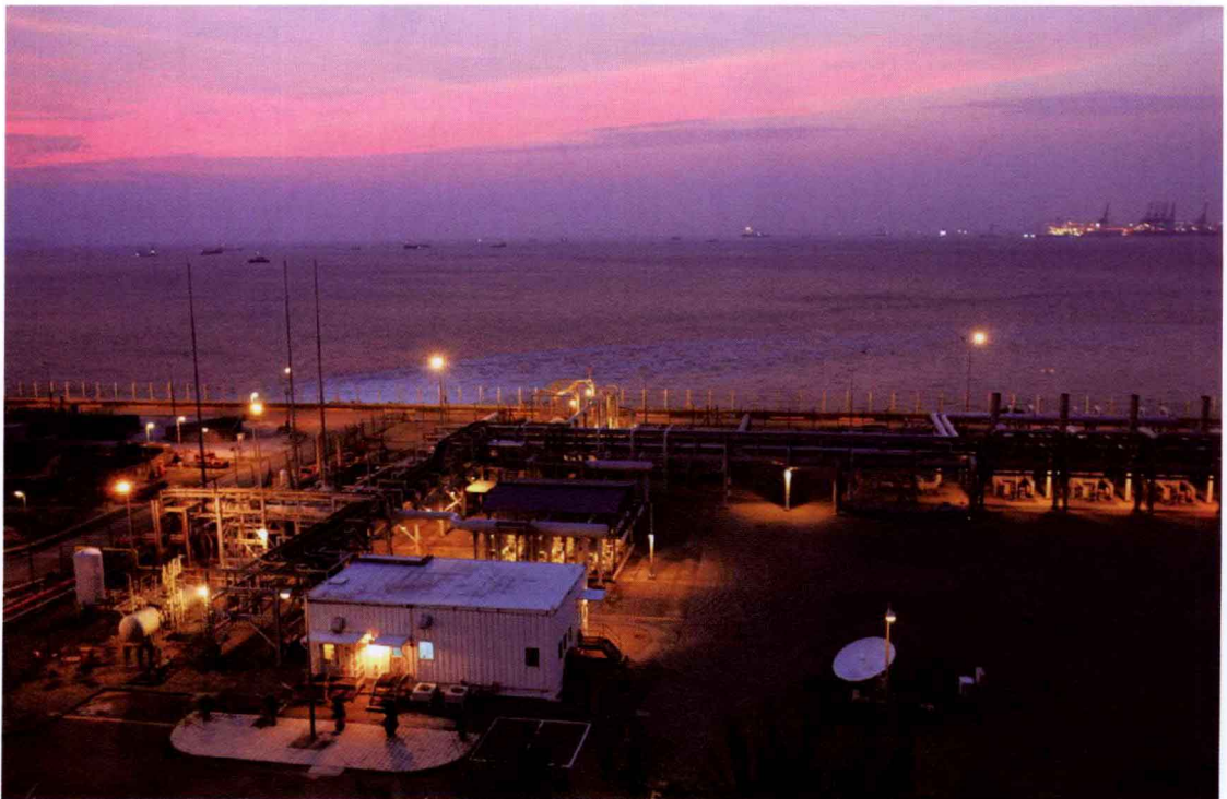
崖城 13-1 气田香港干气接收终端全景照片
