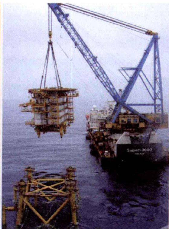
建设中的气田
