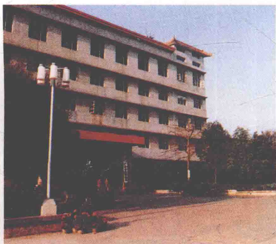
广东农垦总局办公大楼
