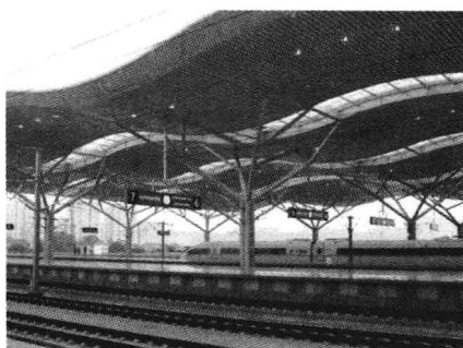
图 1-7 长沙高铁站空间钢管结构
