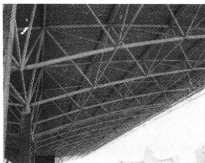
图 1-6 某体育馆看台网架结构
