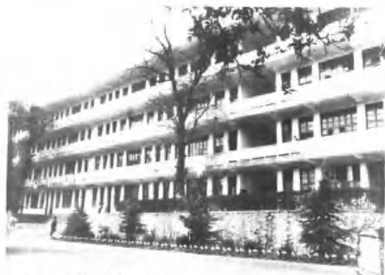
(4)、祁阳二中教学大楼
