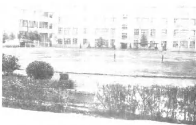
(16)、人民完小教学大楼
