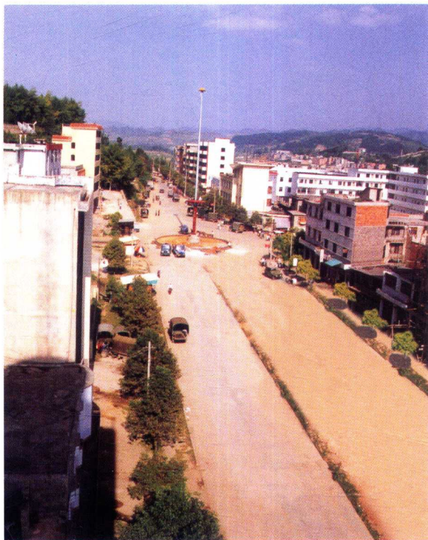
建设中的新县城一角
