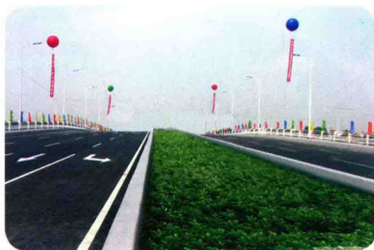
南寨横跨铁路双向大桥
