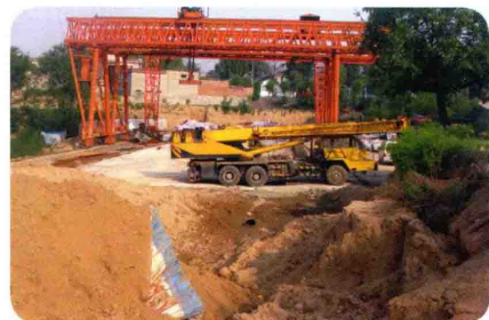
南寨横跨铁路大桥施工现场
