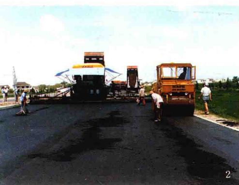
1 中央、市、局领导参加沪宁高速公路奠基仪式 2 机械化摊铺施工
