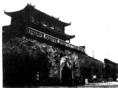
随枣、枣宜两次会战 中，襄阳均发生激战。图 为战后修复的襄阳小北门 城楼。（襄樊市政协供稿）
