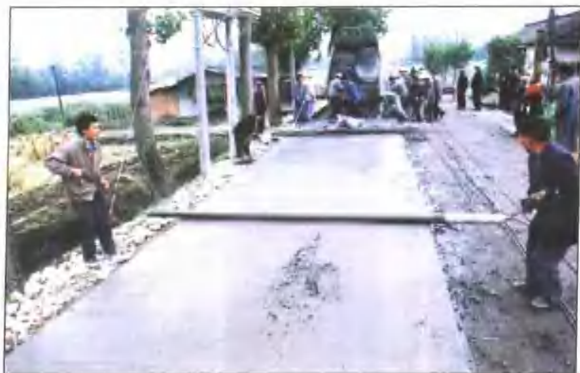
高埂镇村村通水泥路施工现场
