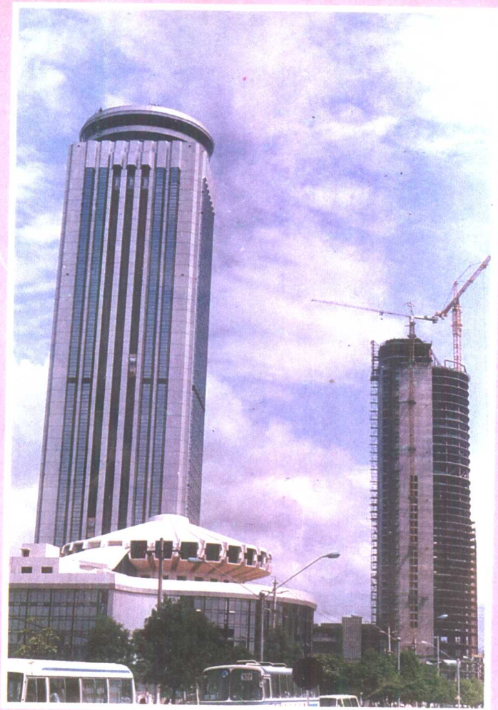
17 國貿中心大廈 (右後為施工中的發展中心大廈)
