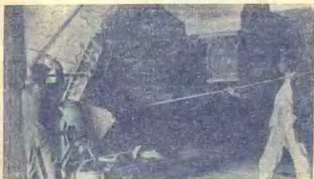
侵風冷免以，開鋸間時的灰扒把煤省合理友工灰推 。度溫了持保，內爐入
