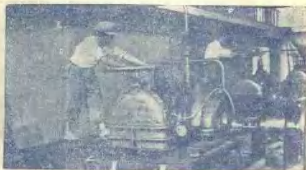
既，（右左度七十九在度溫水路）量水却冷節調當適房氣水 。度溫的水結凝的機汽加魯父電省
