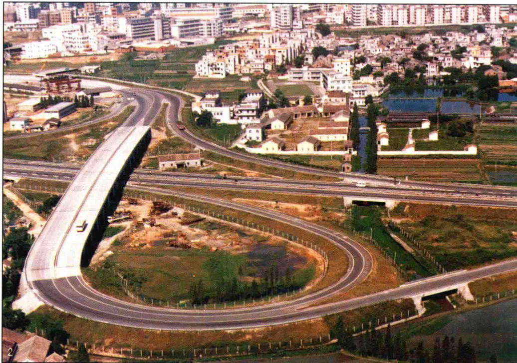
2 广(州)——佛山高速公路大沥互通立交桥
