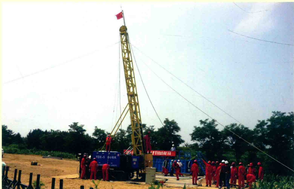
2009年8月1日，中国地质科学院勘探技术研究所2000米全液压岩心钻探装备示范工程在山东省乳山市金州金矿开工。
