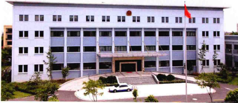
◀ 泗门分局办公楼
