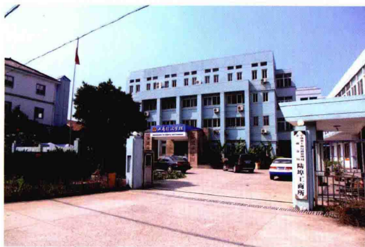
▶ 陆埠工商所办公楼
