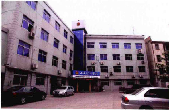
江北工商所办公楼 ▶
