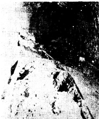
图 8 底鼓使底板隆起，破坏了铁道
