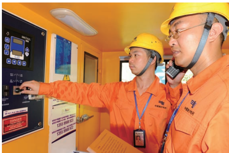
○ 东莞供电局反事故实战演练现场。
