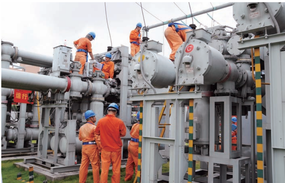
○ 东莞供电局开展反事故实战演练迎亚运。 龚琳 / 摄
