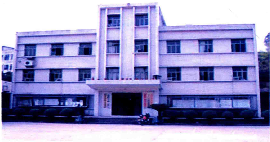
政府办公大楼
