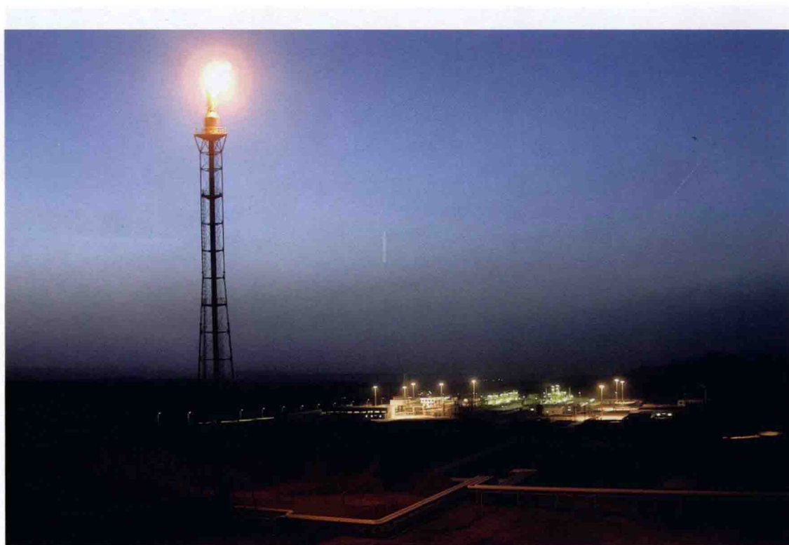
2004 年 11 月 28 日，克拉 2 气田中央处理厂试投产一次成功。 图为厂区夜景（丁和平摄）
