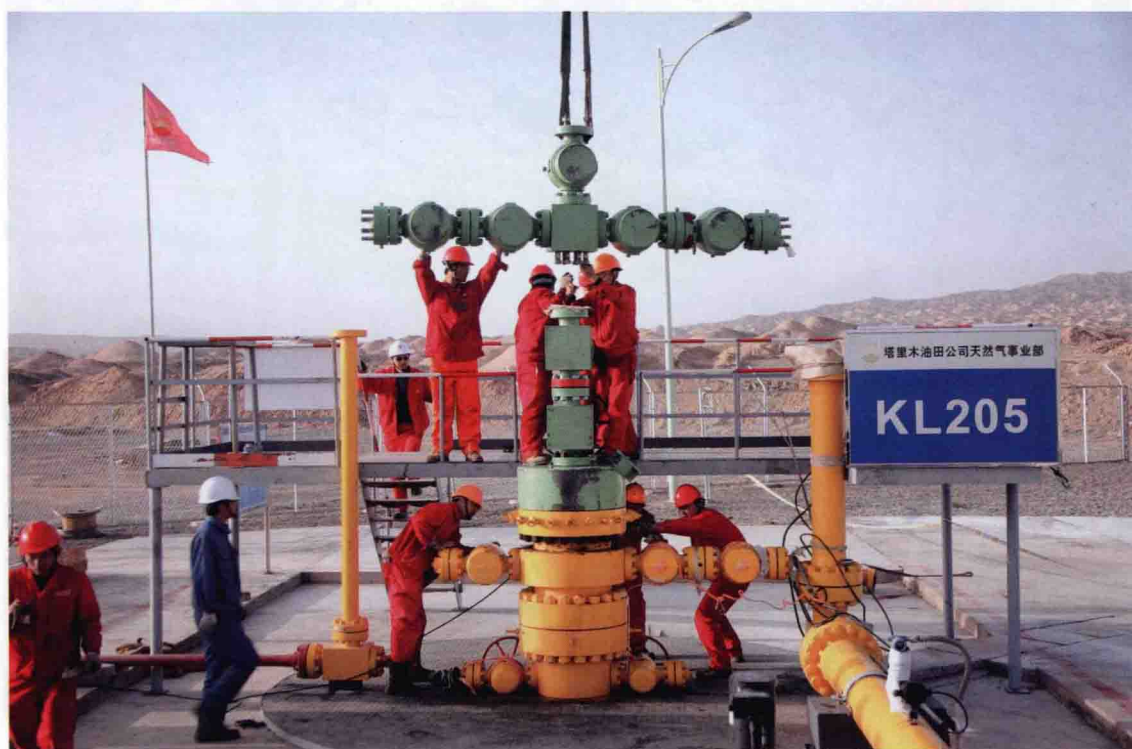
塔里木油田首次成功在克拉 205 井实施了三高气井不压井带压更换采气树作业（熊斌摄）
