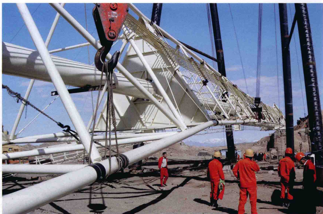
2004年9月3日，克拉2气田火炬塔起吊（唐全宏摄）
