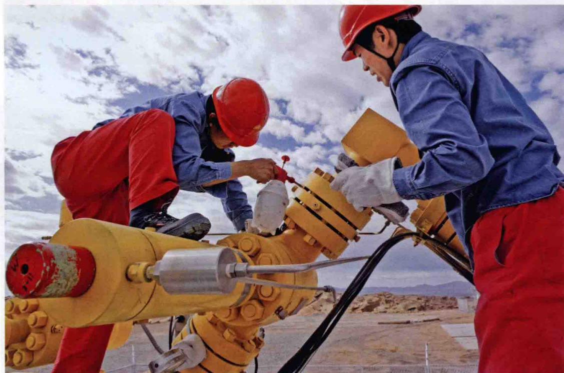
克拉2气田气井检漏（项目组供稿）
