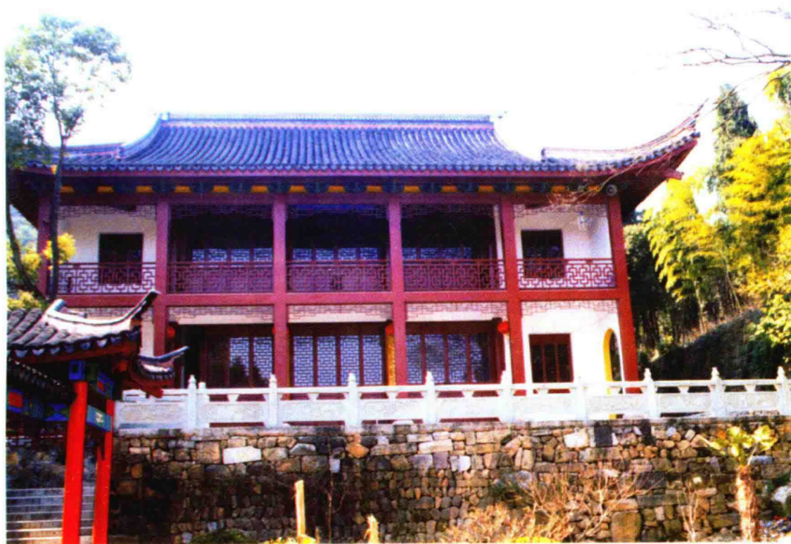
新建法堂(方丈室)
