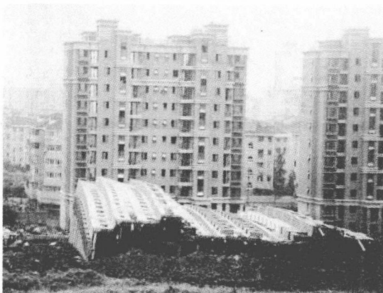
图 1.1 某楼房倒塌图
