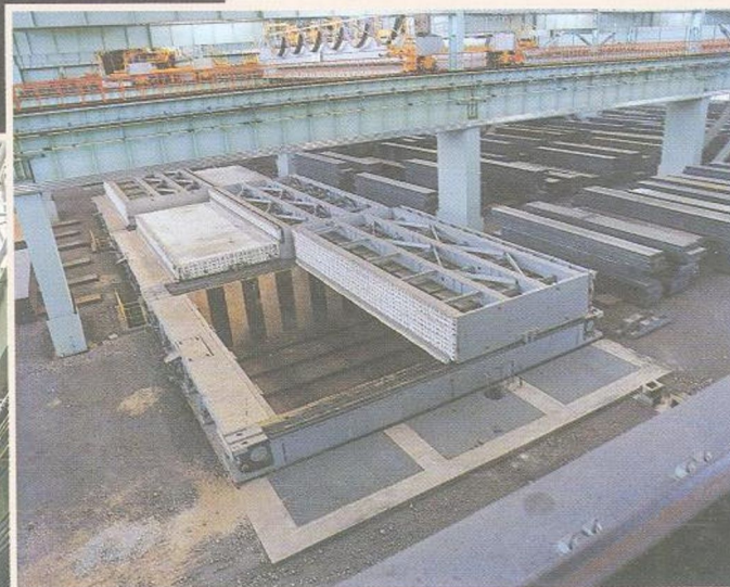
保温坑用于存放連鑄車間送來的熱板坯
