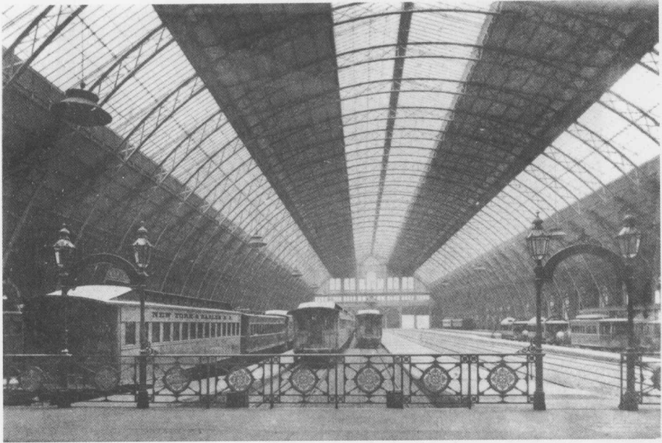
▲ 此图展示的是大中央车站车库的内部，其顶部是庞大的弧形玻璃屋顶。请注意右边远处的马拉街车，它们通过一个南部的入口进入该车站。（纽约中央铁路历史协会）
