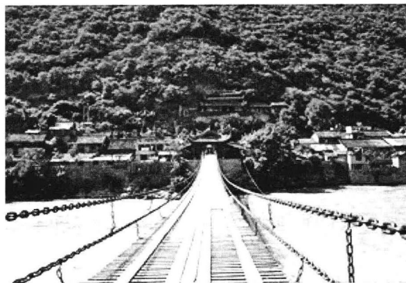
图 1.8 大渡河铁索桥——泸定桥
