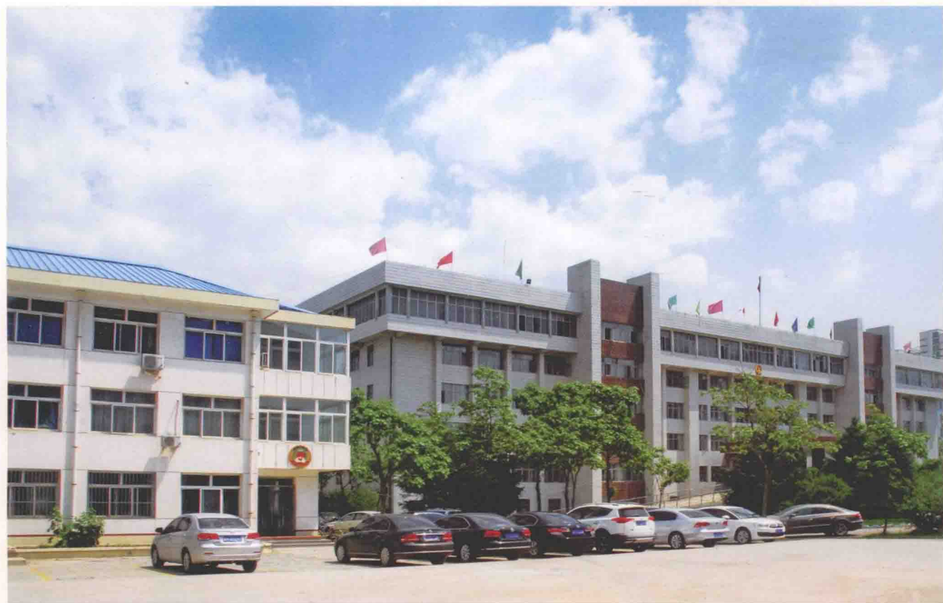
隆化县委、政府、政协办公楼
